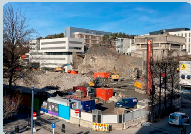
Sandvika Helgerudkvartalet byggeplass
