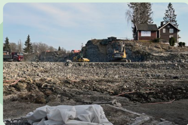
Kleivveien nord byggeplass
